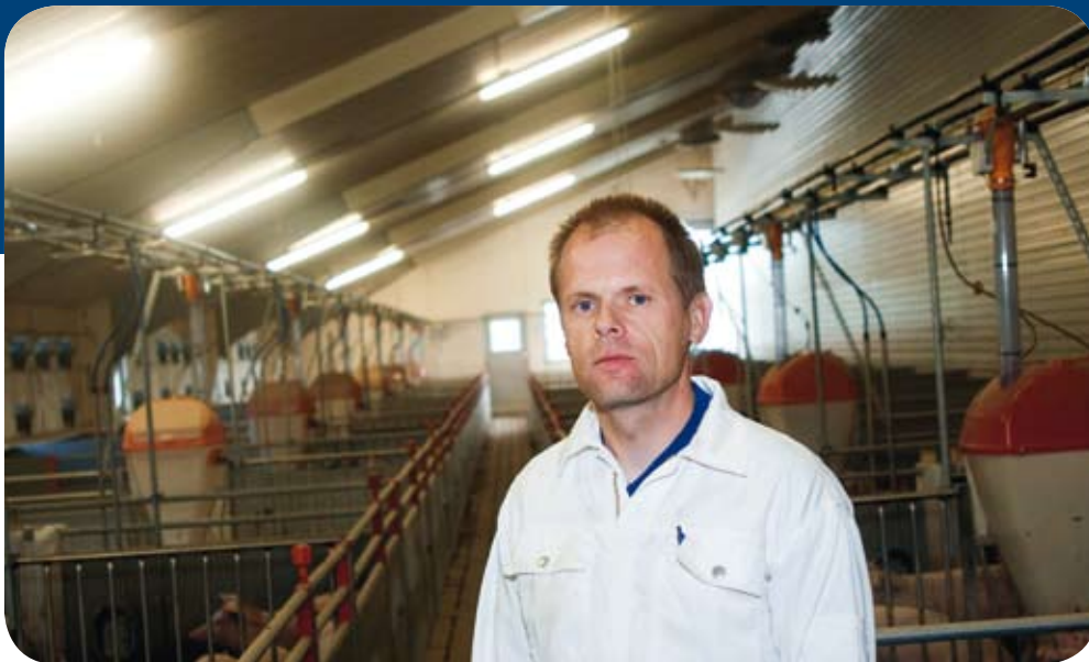
Lars Bredstrup i stalden, hvor ventilationsanlægget kunne genbruges fra fjerkræstalden.
