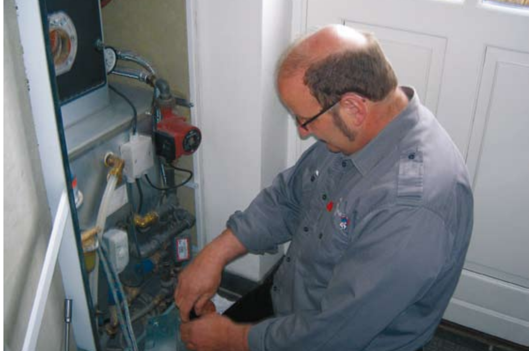
Der arbejdes på, at oliekedler skal have et årligt tjek, som først og fremmest skal indeholde en energimåling.
